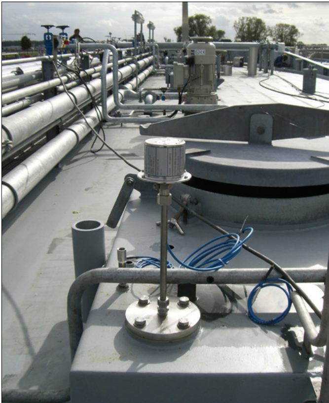
Fig. 2: Level Plus® Transmitter auf der Commodore II.
